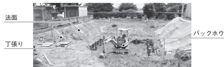
図表7 掘削工事
